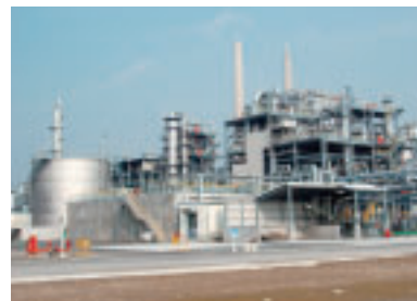
東ソー(株)向け 第二アニリン製造設備
