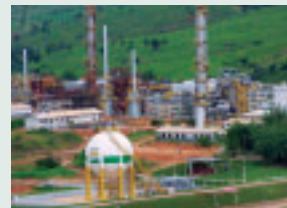
ブラジル国営石油公社向け ガス処理設備
