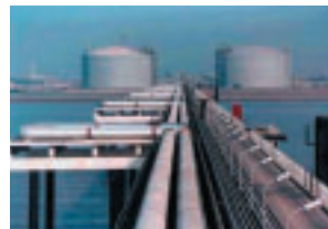
インド ペトロネットLNG社向け 液化天然ガス (LNG) 受入基地
