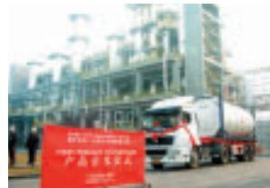
中国・BASF-YPC社向け アクリル酸・アクリル酸エステル製造プラント
