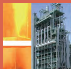
左:アンモニアバーナ燃焼の様子 右:ナフサ分解炉の全体像
